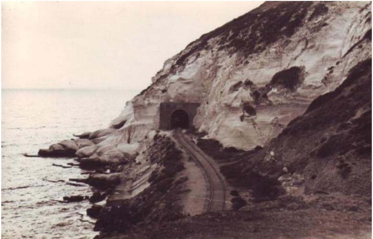
Grenztunnel der Strecke von Haifa nach Tripolis bei Rosch haNikra
