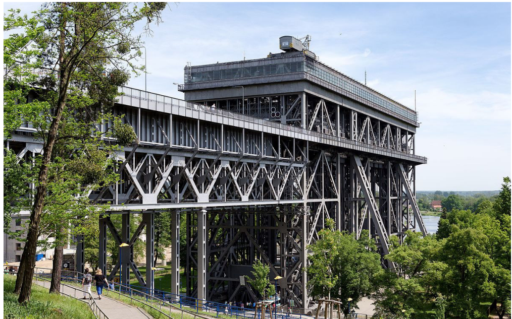
Bild 3: Schiffshebewerk Niederfinow am Oder-Havel- Kanal, erbaut von 1927 bis 1934; Hubhöhe 36 m, Hubdauer 5 min, Schleusungsdauer 20 min; das Hebewerk ersetzte vier Kammer- schleusen [13].
